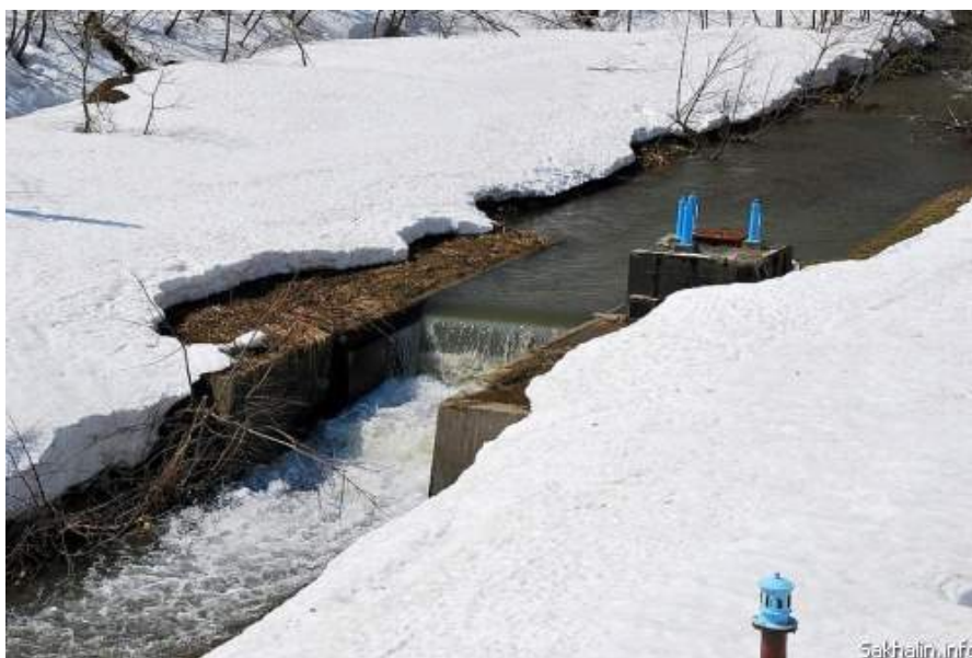
Дамба на ручье для водозабора
